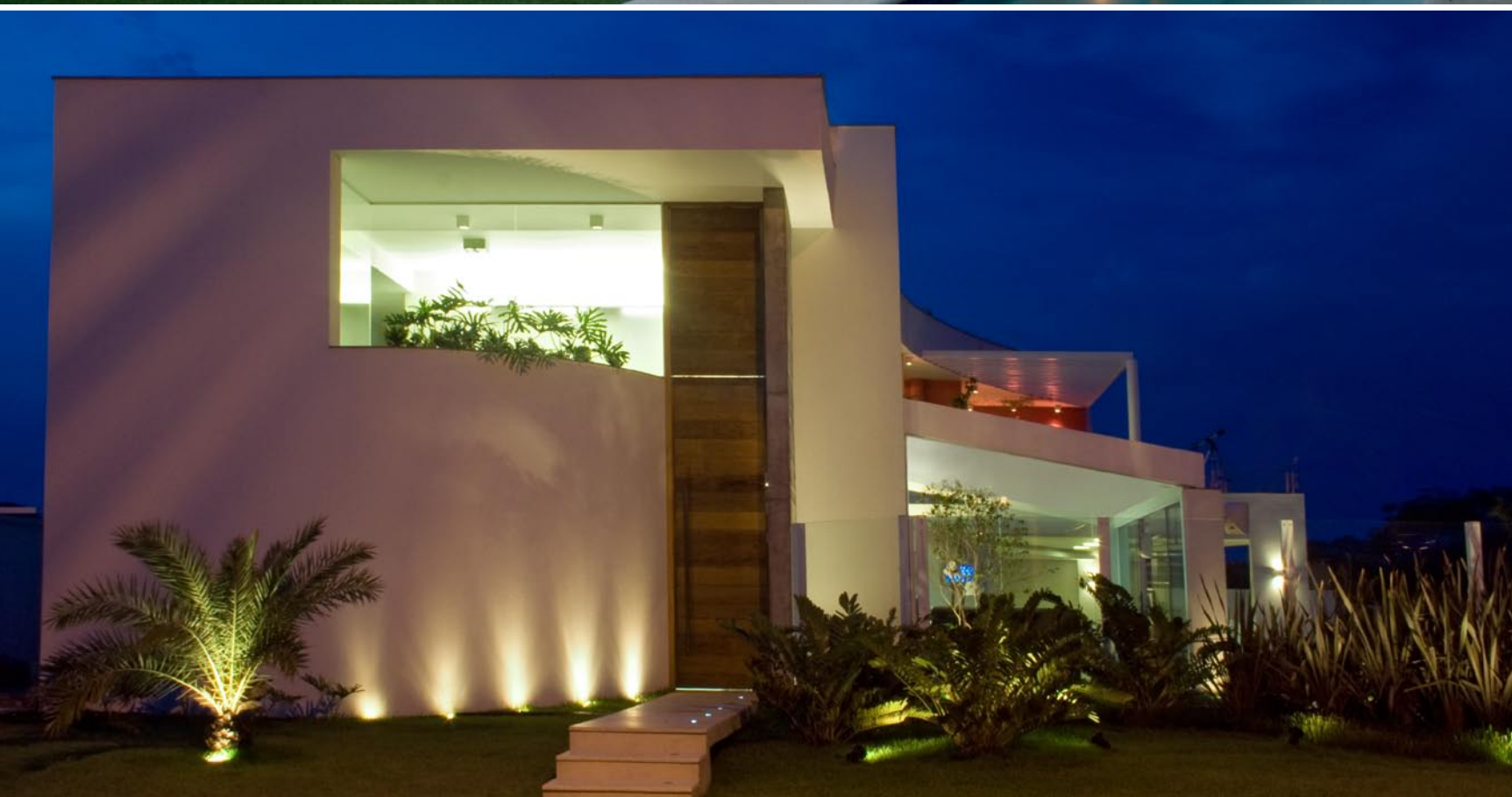
Posicionada na parte posterior do lote, a casa, com suas curvas suaves e cores vibrantes, abraça a área de lazer e se volta para o bosque. A transparência dos ambientes propicia a total integração com a área externa ajardinada
